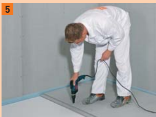
5 Spojovací prvky: šrouby Powerpanel ...
