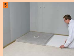
5 Varianta 1b: ve výši horní hrany korpusu odtoku je celá plocha pokryta rychlotuhnoucím podsypem a poté usazen sprchový prvek
