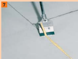
7 Vypěněné lepidlo po vytvrdnutí odstraňte
