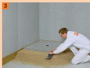
3 Varianta 1b: aby byla dosažena výška stupňovité drážky sprchového prvku, je po ploše umístěna izolace (EPS DEO 150) ve vrstvě 10 mm
