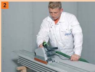
2 U první řady odřízněte drážku
