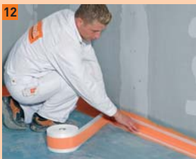
12 Do vlhké tekuté fólie vtlačte těsnicí pásy FERMACELL
