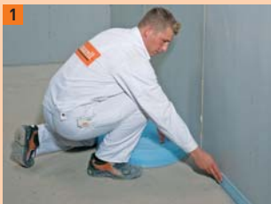
1 Položení okrajového izolačního pásku
