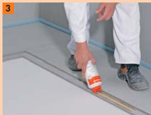
3 Na plochu drážky naneste podlahové lepidlo FERMACELL
