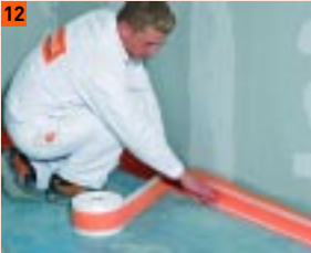
12 Na mokrą folię docisnąć taśmę uszczelniającą
