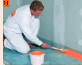
11 Płynną folię FERMACELL nanieść w narożach pędzlem
