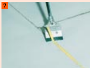
7 Nadmiar kleju do jastrychów ściąć po wyschnięciu
