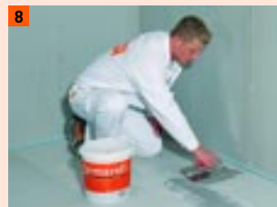
8 Spoiny i elementy mocujące szpachlować wg potrzeby
