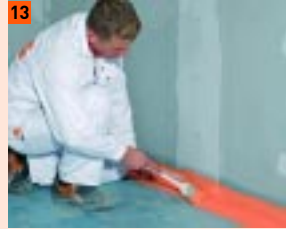
13 W drugim cyklu roboczym pokryć taśmę uszczelniającą płynną folią FERMACELL
