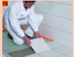
15 Naklejanie płyt ceramicznych na cienkiej lub grubej warstwie kleju
