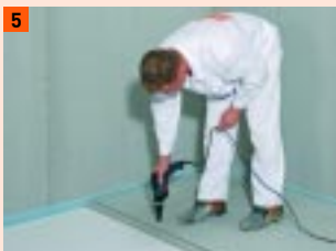
5 Stosować: wkręty samogwintujące Powerpanel...
