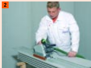
2 Elementom pierwszego rzędu odciąć zakładki
