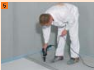
5 Stosować: wkręty samogwintujące Powerpanel...
