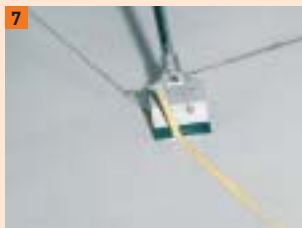
7 Nadmiar kleju do jastrychów ściąć po wyschnięciu
