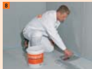
8 Spoiny i elementy mocujące szpachlować wg potrzeby
