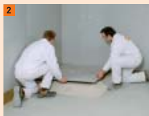
2 Wariant 1a: powierzchnię elementu odpływowego wypełnić podsypką fix FERMACELL, osadzić element odpływowo, ściągnąć nadmiar podsypki do wysokości górnej krawędzi kratki
