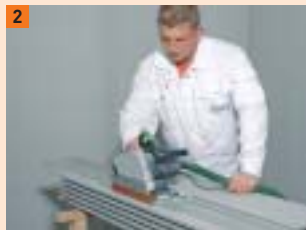
2 Elementom pierwszego rzędu odciąć zakładki
