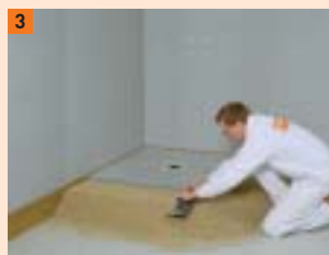
3 Wariant 1a: naokoło elementu odpływowego usypać warstwę podsypki fix na szerokość ca 200 mm i ściągnąć nadmiar na poziomie górnej krawędzi zakładki
