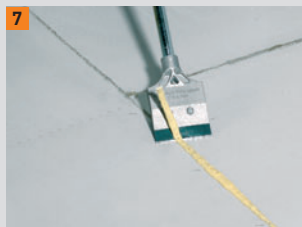
7 Nadmiar kleju do jastrychów ścierać po wyschnięciu
