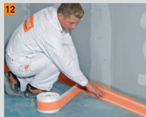
12 Na mokrą folię docisnąć taśmę uszczelniającą
