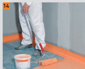
14 W dwóch cyklach roboczych walcem nanieść płynną folię FERMACELL
