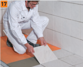
Naklewanie płyt ceramicznych na cienkiej lub grubej warstwie kleju
