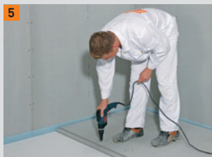
5 Elementy mocujące: wkręty samogwintujące Powerpanel
