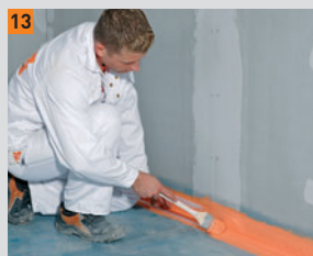
13 W drugim cyklu roboczym pokryć taśmę uszczelniającą płynną folię FERMACELL
