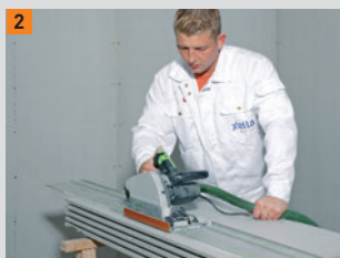
2 Elementom pierwszego rzędu odciąć zakładki
