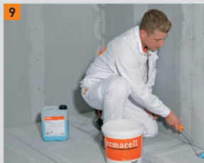
9 Gruntować gruntem FERMACELL najpierw na obrzeżach pomieszczenia...
