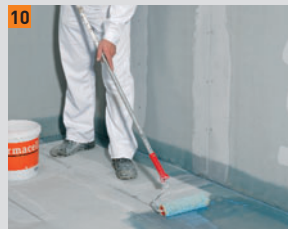
10 ... a następnie walcem na powierzchni całej podłogi...
