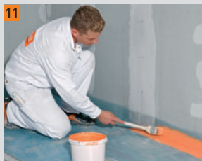
11 Płynną folię FERMACELL nanieść w narożach pędzlem
