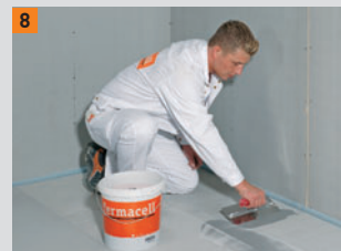
8 Spoiny i elementy mocujące szpachlować wg potrzeby
