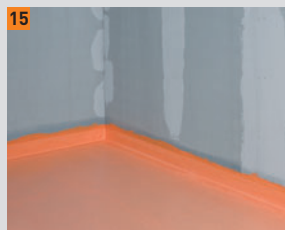
15 Zastosowanie systemu uszczelniającego FERMACELL na całej powierzchni pozwala osiągnąć o wysoką odporność na wilgoć
