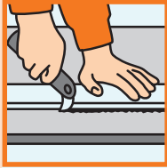
Nacięcie nacięcie nożem FERMACELL
