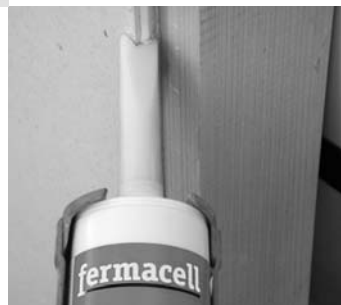
Ilustracja 20: Prowadzenie kartusza o objętości 310 ml po krawędzi. Nowa dysza umożliwia nanoszenie właściwej ilości kleju na krawędzie płyt o grubości 10 mm i 12,5 mm. Do płyt o grubości 15 mm i 18 mm dyszę trzeba odpowiednio dociąć.
