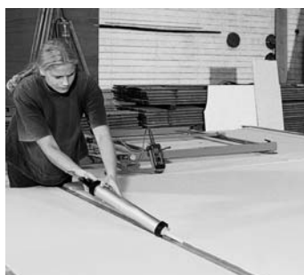
Ilustracja 19: Nanoszenie kleju do spoin FERMACELL z wykorzystaniem praktycznego opakowania foliowego o pojemności 580 ml
