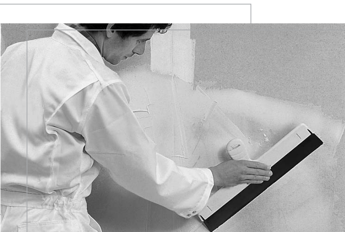
Ilustracja 30: Szpachlowanie finalną masą szpachlową
