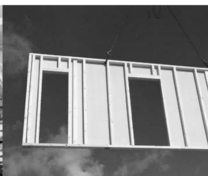
Ilustracja 4: Przenoszenie dźwigiem na budowie
