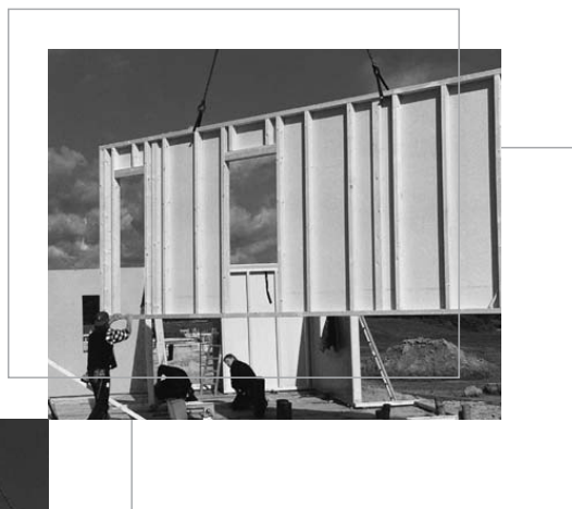
Ilustracja 5: Montaż na budowie
