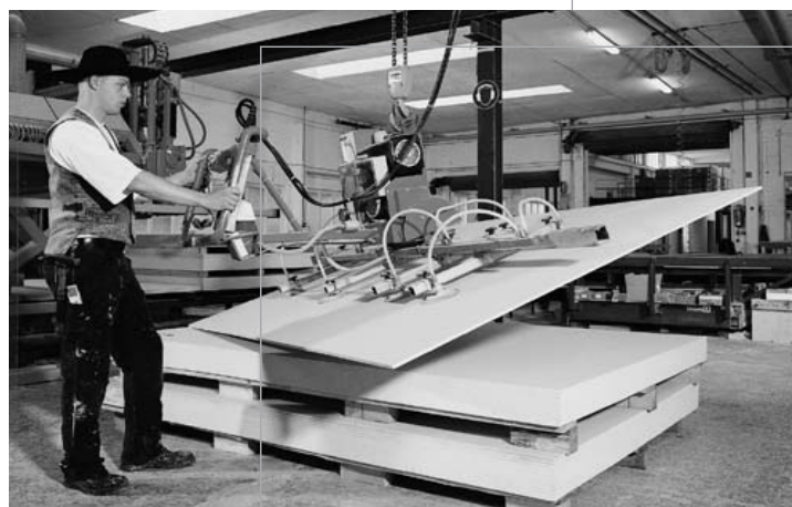
Ilustracja 2: Przenoszenie płyt gipsowo-włóknowych FERMACELL podciśnieniowym podnośnikiem do płyt
