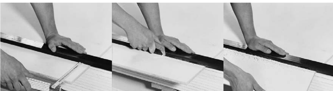
Ilustracja 11: Wymierzanie miejsca łamania
