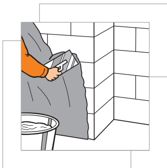
Rysunek 17: Na ścianach kominowych warstwa kleju nanoszona jest na całość powierzchni, potem przykleja się płytę FERMACELL
