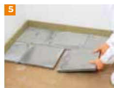
Powerpanel SE układamy systemem ciągłym, tak że nie powstają żadne odpady
