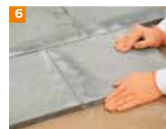
Płyty zostają szczelnie dosunięte do siebie (szerokość spoiny ok. 1-1,5 mm)
