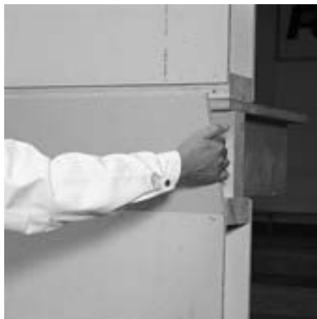
Ilustr. 4.11: Montaż paska płyt
