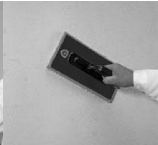
Ilustr. 3.17: Zacieranie powierzchni tynku pacą obłożoną gąbką
