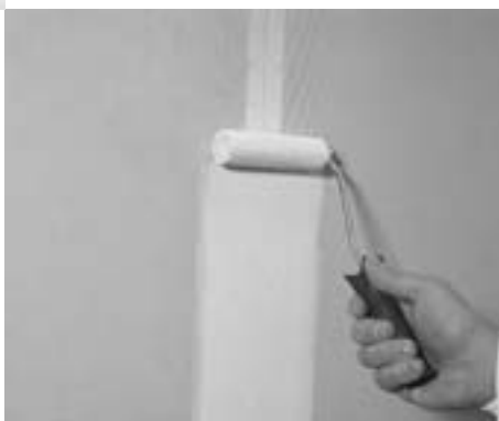
Ilustr. 3.14: Nanoszenie kleju FERMACELL HD wałkiem
