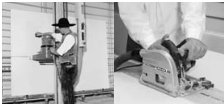
Ilustr. 3.1: Przycinanie płyt za pomocą pilarki formatówki
