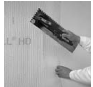
Ilustr. 3.20: Wykonywanie zakładek siatki wzmacniającej o szer. ok. 10 cm
