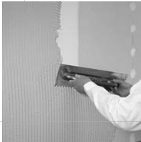
Ilustr. 3.16: Nakładanie lekkiej wyprawy tynkowej FERMACELL HD
