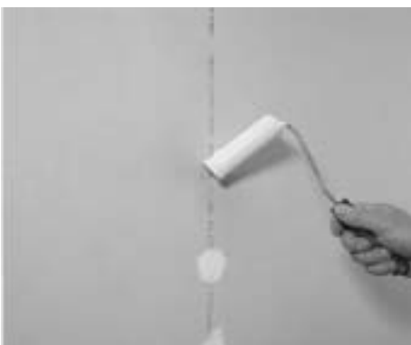
Ilustr. 3.15: Pokrywanie klejem elementów łączących w środku płyty
