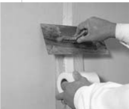
Ilustr. 3.13: Przyklejanie taśmy wzmacniającej FERMACELL HD
