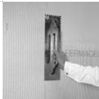
Ilustr. 3.19: Taśmę wzmacniającą FERMACELL HD wcisnąć w masę szpachlową
