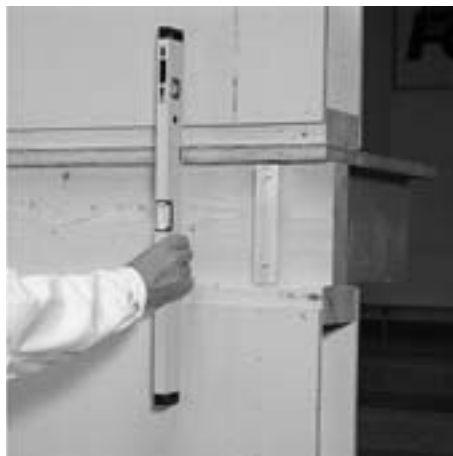
Ilustr. 4.10: Wyrównujący element ściany
