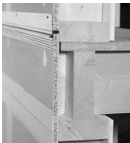
Ilustr. 4.15: Gotowy zmontowany pas płyt z profilem międzykondygnacyjnym FERMACELL HD
