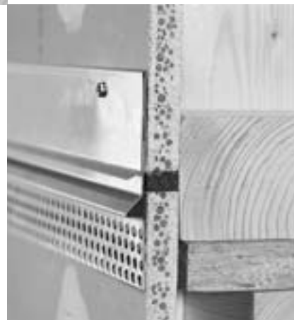
Ilustr. 4.14: Upchna taśma uszczelniająca w celu tymczasowego zabezpieczenia przed czynnikami atmosferycznymi
