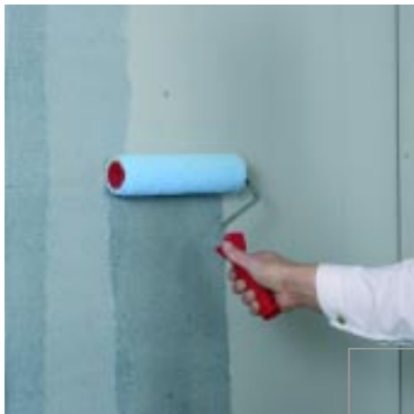
Zdjęcie 1: nanieść grunt FERMACELL
