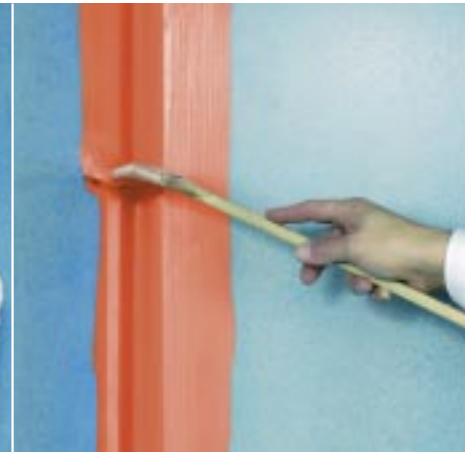
Zdjęcie 2: taśmę uszczelniającą FERMACELL docisnąć na mokrą powłokę z płynnej folii FERMACELL i w 2 cyklu roboczym zamałować płynną folią FERMACELL
