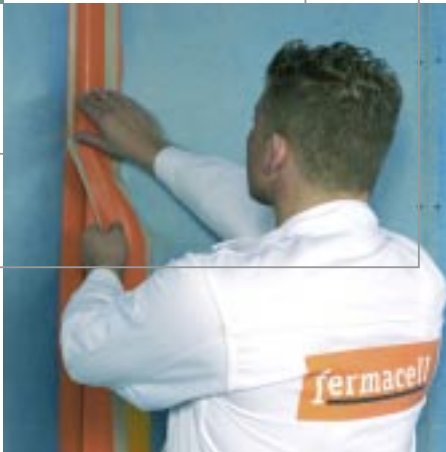
Zdjęcie 2: taśmę uszczelniającą FERMACELL docisnąć na mokrą powłokę z płynnej folii FERMACELL i w 2 cyklu roboczym zamałować płynną folią FERMACELL
