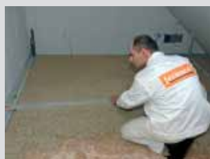
Nasypaná hmota se v prostoru mezi násypy rovně stáhne
