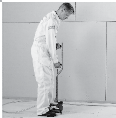
Jednoduché a úsporné sponkování podlahových desek
