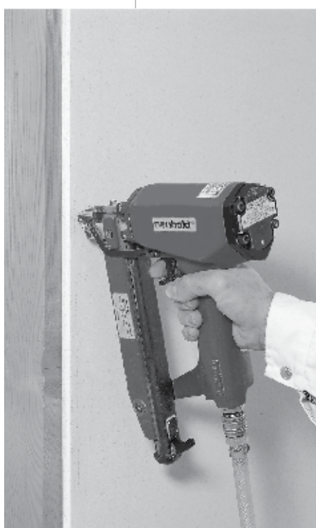
Sponkování desek FERMACELL na dřevěnou spodní konstrukci
