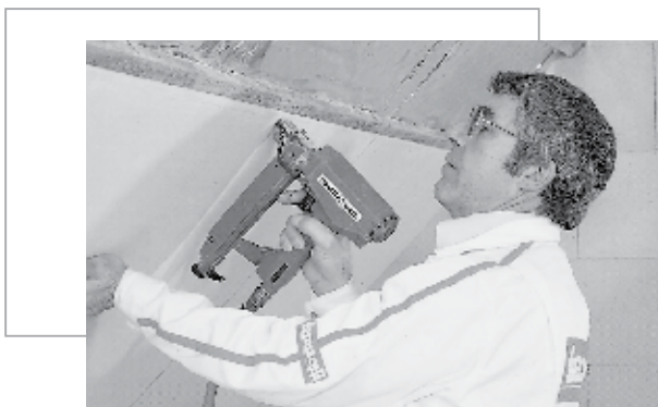
Snadné upevňování desek sponkami na stropy a střešní šikminy
