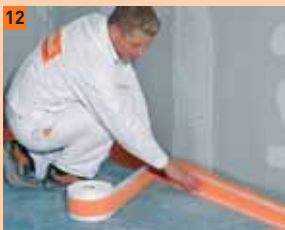
12 Do vlhké tekuté fólie vtlačte těsnicí pásky FERMACELL
