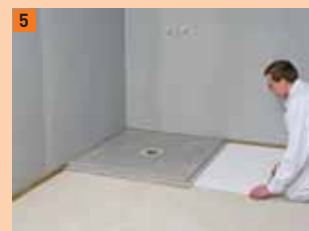
5 Varianta 1b: ve výši horní hrany korpusu odtoku je celá plocha pokryta rychlotuhnoucím podsypem a poté usazen sprchový prvek
