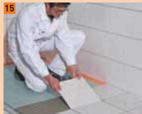
15 Do tenkovrstvého nebo středně silného lože lze pokládat dlaždice
