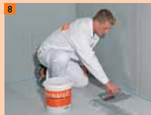
8 Podle potřeby spárování stykové spáry a spojovacích prvků
