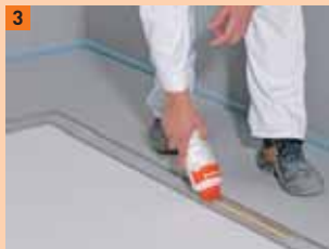
3 Na plochu drážky naneste podlahové lepidlo FERMACELL
