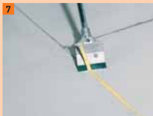
7 Vypěněné lepidlo po vytvrdnutí odstraňte
