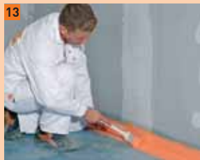
13 Ve 2. pracovní operaci přetřete těsnicí pás tekutou fólií FERMACELL
