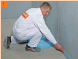
1 Položení okrajového izolačního pásku
