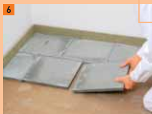
6 Podlahové prvky Powerpanel SE jsou vázány s přesahem, takže v podstatě nevzniká žádný prořez
