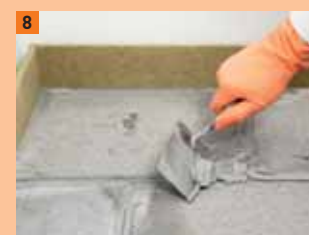
8 Přebytečné lepidlo je lžící setřeno a znovu použito
