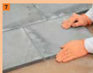
7 Prvky jsou přisunuty těsně k sobě (tloušťka spáry 1–1,5 mm)
