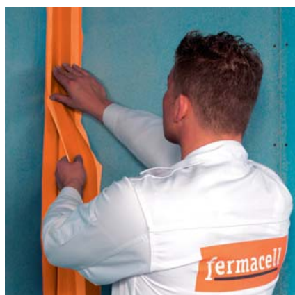
Obr. 5 Lepení těsnicí pásky v oblasti rohů
