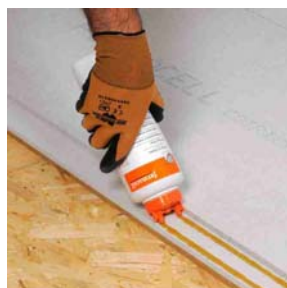
Nanášení lepidla na polodrážku podlahového prvku FERMACELL
