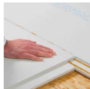
Lepení prvků s kompletně zaplněnými spárami
