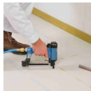
... nebo pomocí rozpěrných sponek (10 minut po nanesení lepidla).
